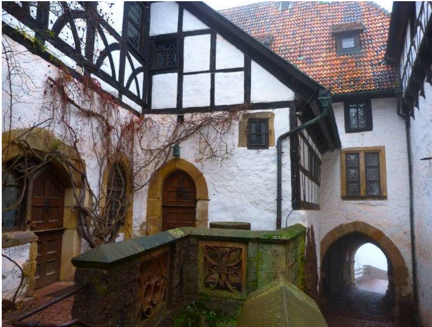
Die Wartburg der erste Innenhof
