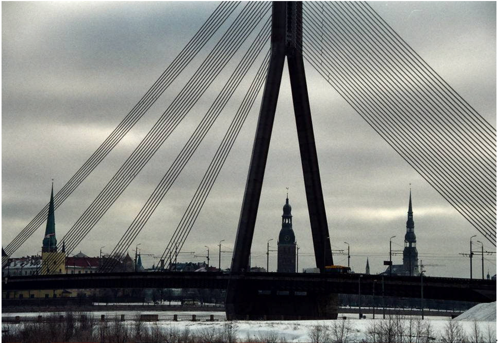
Vanšu tilts (Seilbrücke) über die Daugava (Düna)
