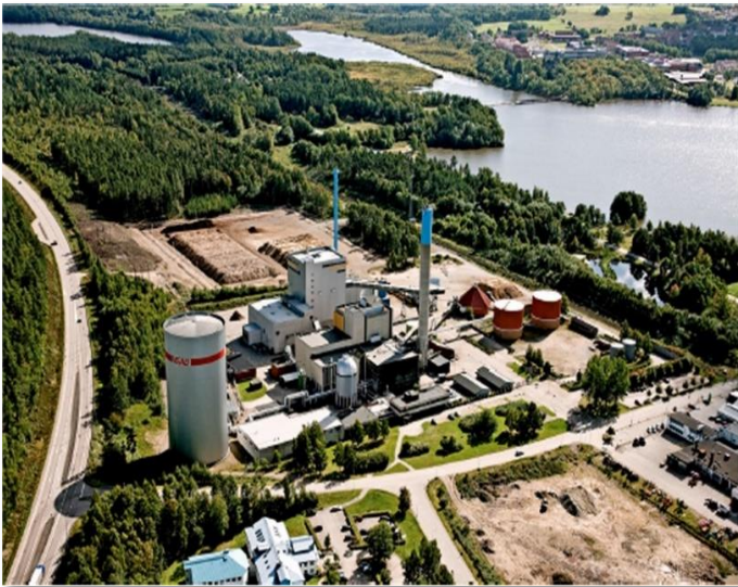
Växjö Biogas-Anlage / Kraftwärmekopplung
