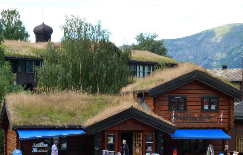
modernes Einkaufszentrum mit ökologischem Grasdach, Lom (N)
