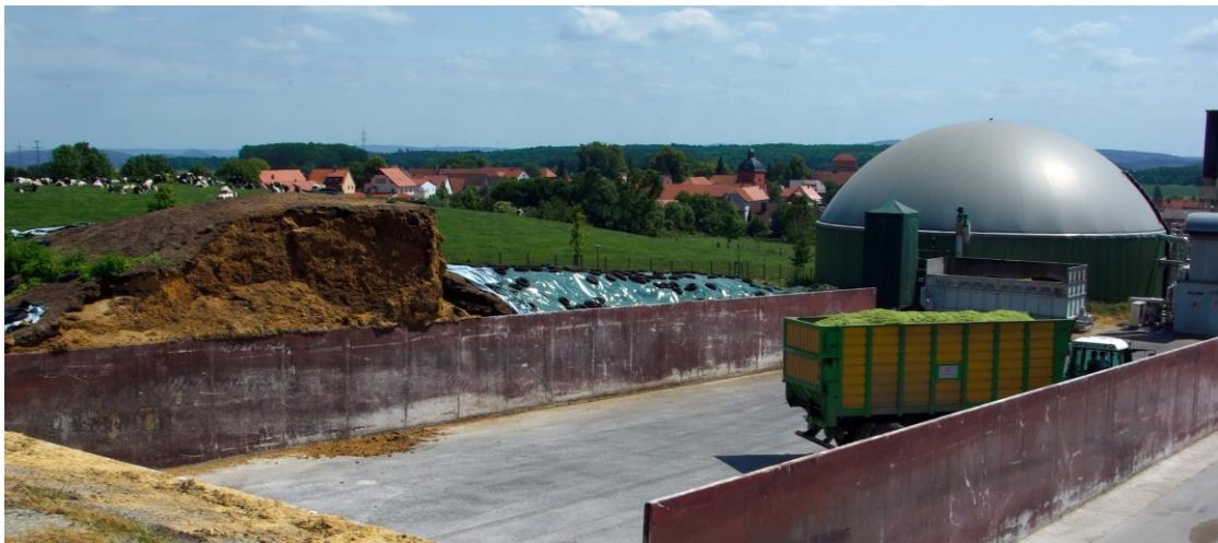
Jühnde, Biogas-Anlage der kurzen Wege zum Dorf, wie es inzwischen viele gibt
