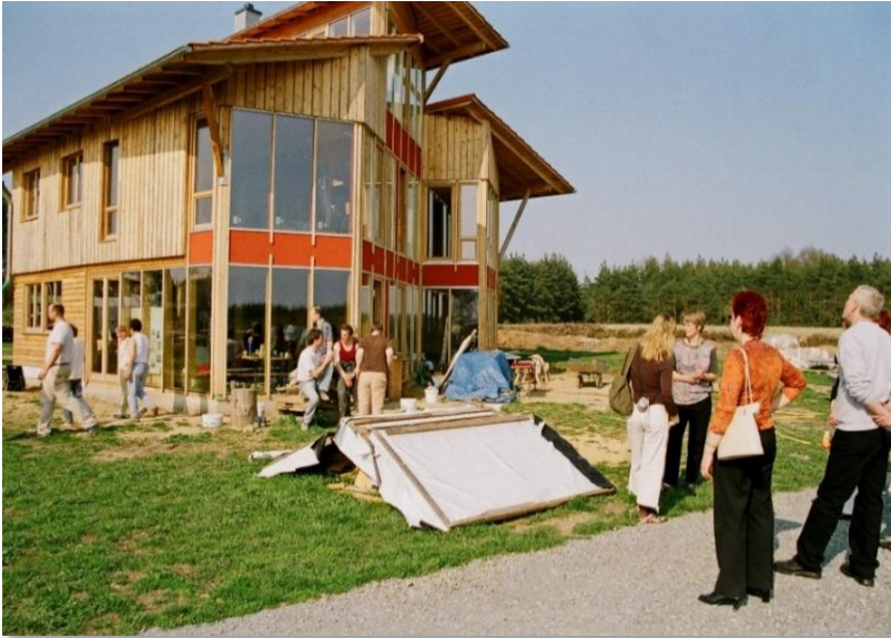
Poppau: gemeinschaftlich erbautes Null-Energie-Gemeinschaftshaus aus Holz
