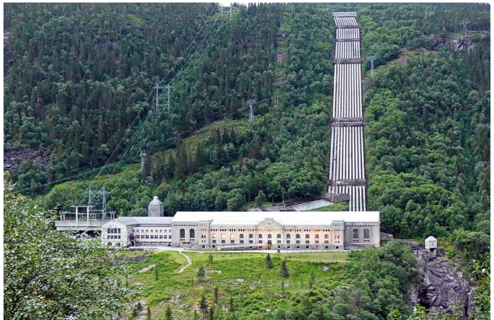
Kraftwerk Vemork: Wasser in Strom und Wasser in Schweres Wasser
