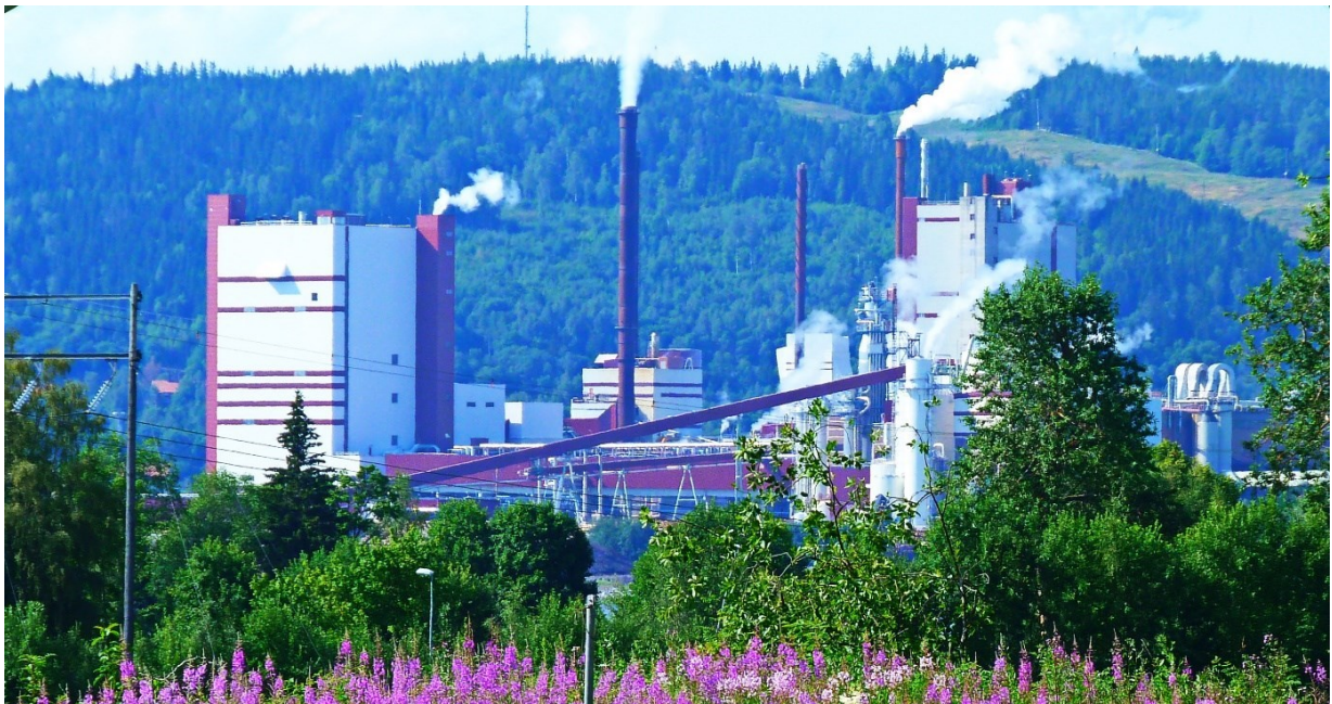
Stora Enso, Holz-Verstromung (hier: Timrå, S)
