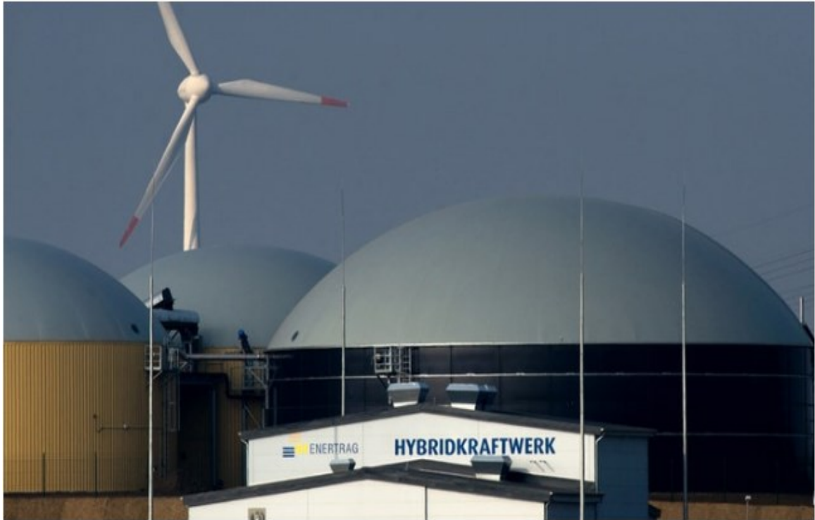
H 2 – Anlage, Brandenburg
