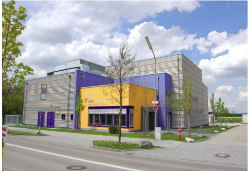
Unterhaching Geothermie- Kraftwerk
