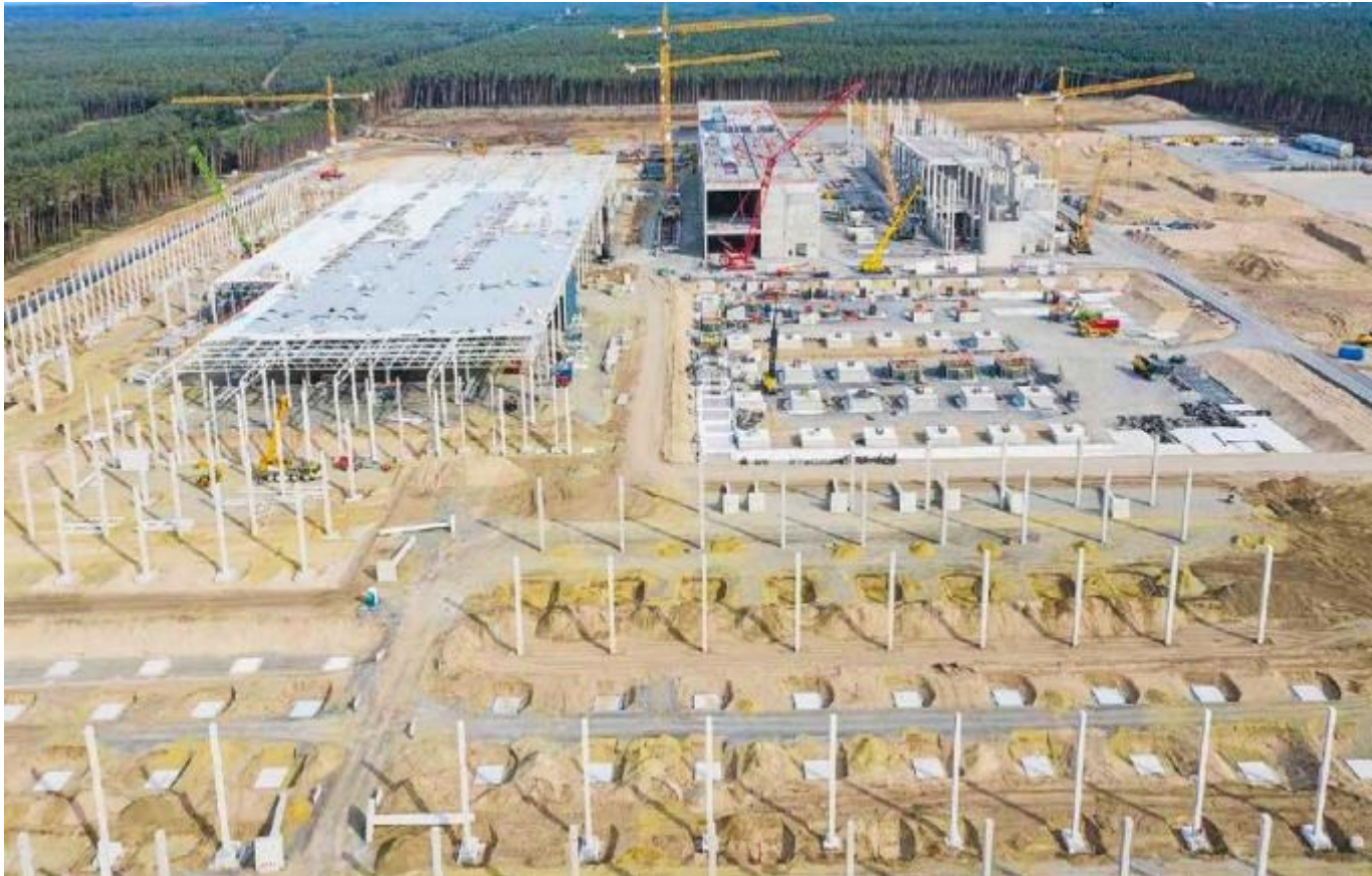
TESLA-Fabrikgelände, Grünheide / Brandenburg
