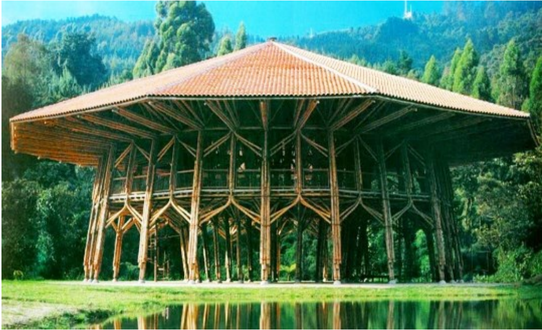
Guadua-Pavillon des Architekten Simón Vélez in Manizales. Wie kann man einen solchen Bau wieder abreißen – um ??
