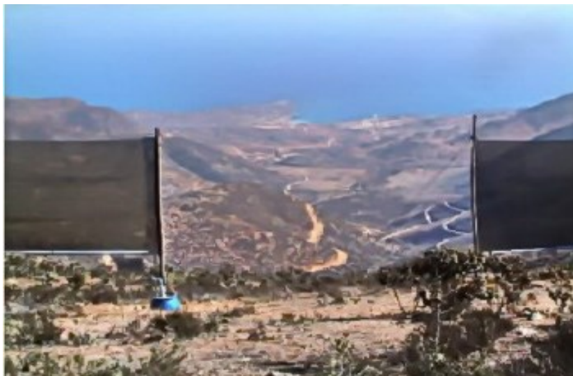
Chungungo: Nebelfänger liefert Trinkwasser aus der Luft 1990
