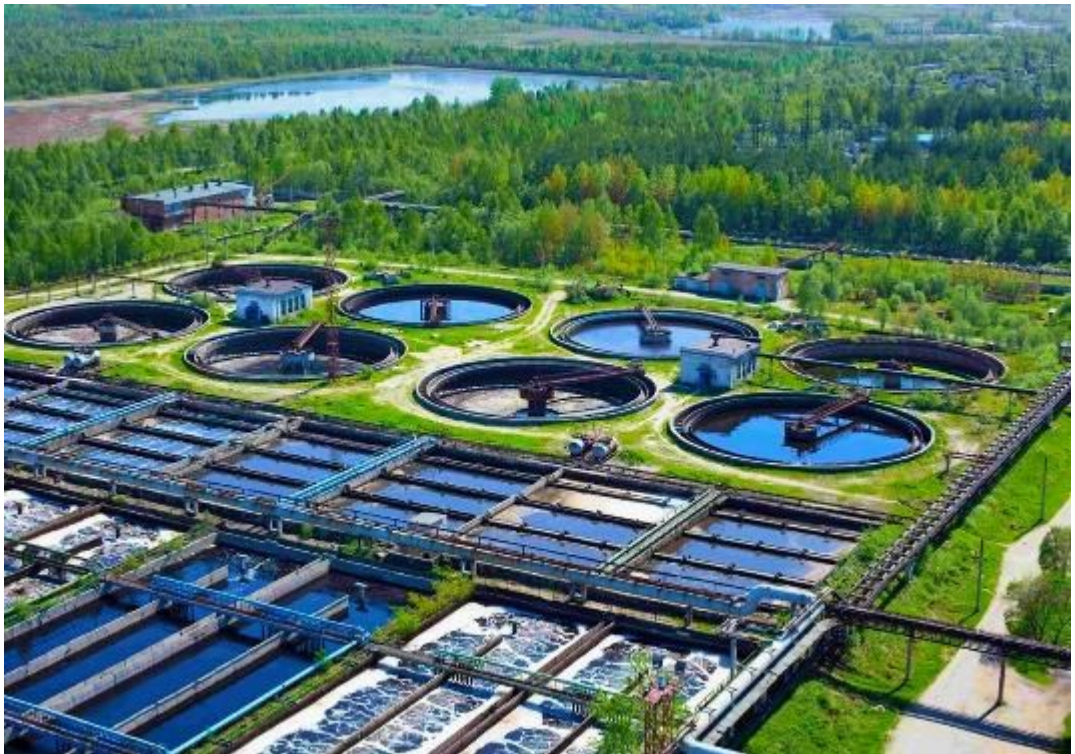
Turku, integrierte Abwasser-Aufbereitung Kakolanmäki
