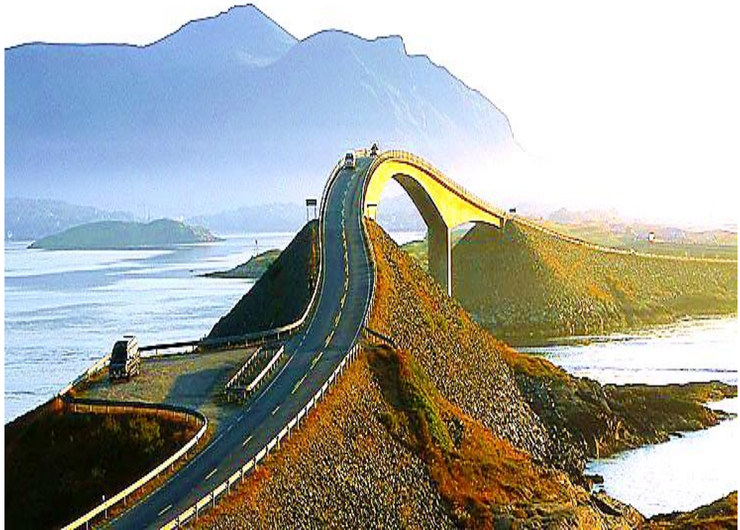
Brücke am Fjord: Møre og Romsdal (N)
