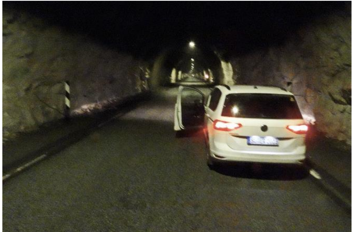
Tunnel der FV 17 - endlos
